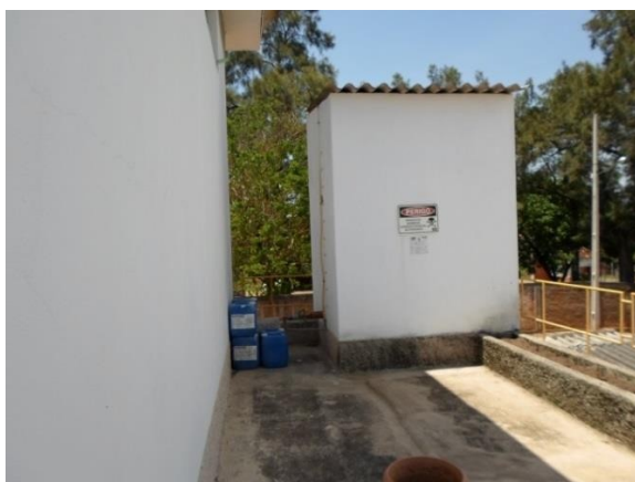
Figura 19: Sala de aplicação do cloro Fonte: Conen
