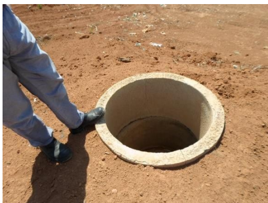
Figura 40: Poço de despejo de lixo anatômico Fonte: Conen
